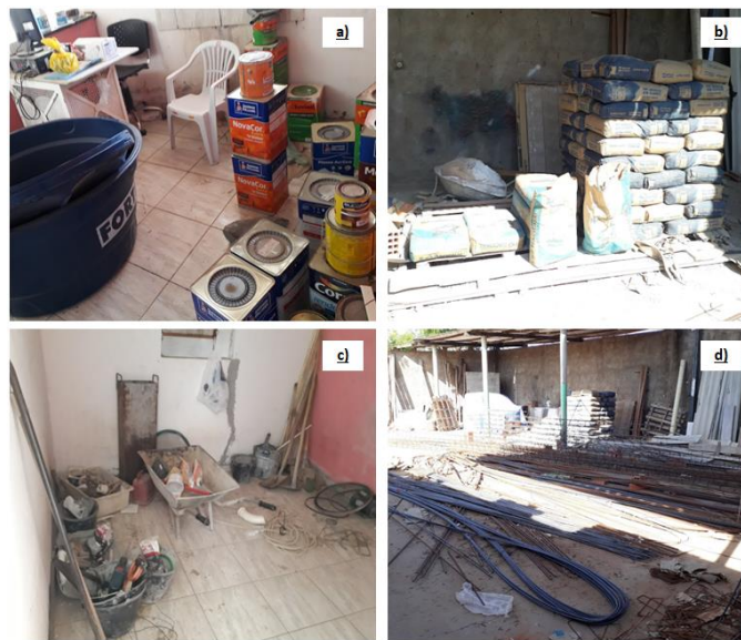
Figura 1. Canteiro de Obras. Fonte: Arquivo Pessoal (2021)
